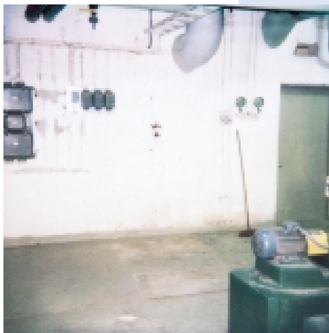
Pumparna är demonterade
